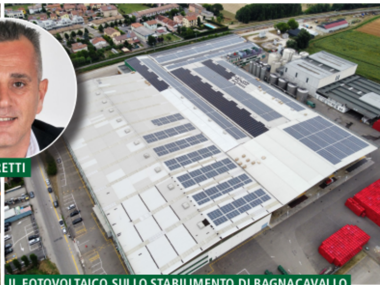
IL FOTOVOLTAICO SULLO STABILIMENTO DI BAGNACAVALLO
